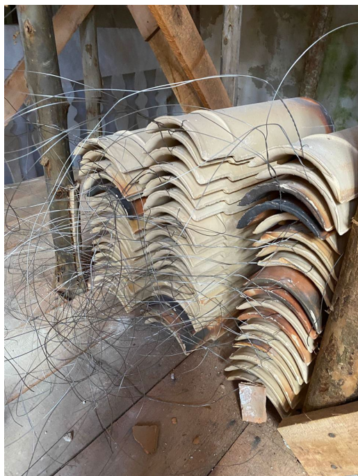
40. Colocação do arame inox 316 para amarração das telhas.
