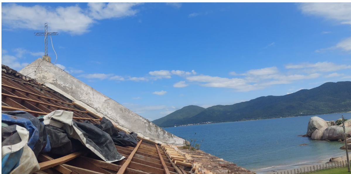
12. Detalhe do plano de cobertura atrás da empena frontal.
