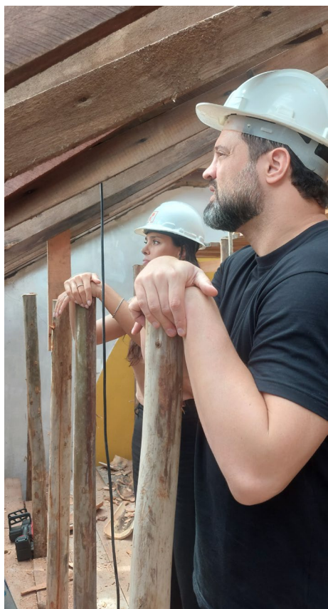
15. Eng. Paula Bogdan, da Serpa Engenharia e Arq. Guilherme Simon, da Prospectiva Arquitetura, inspecionando o madeiramento.
