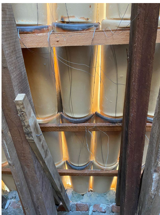
42. Todas as telhas estão sendo amarradas.
