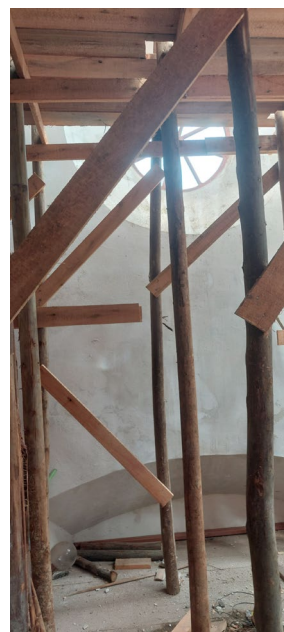
18. Vista interna do andaime/plataforma junto ao óculo frontal, sobre o coro.
