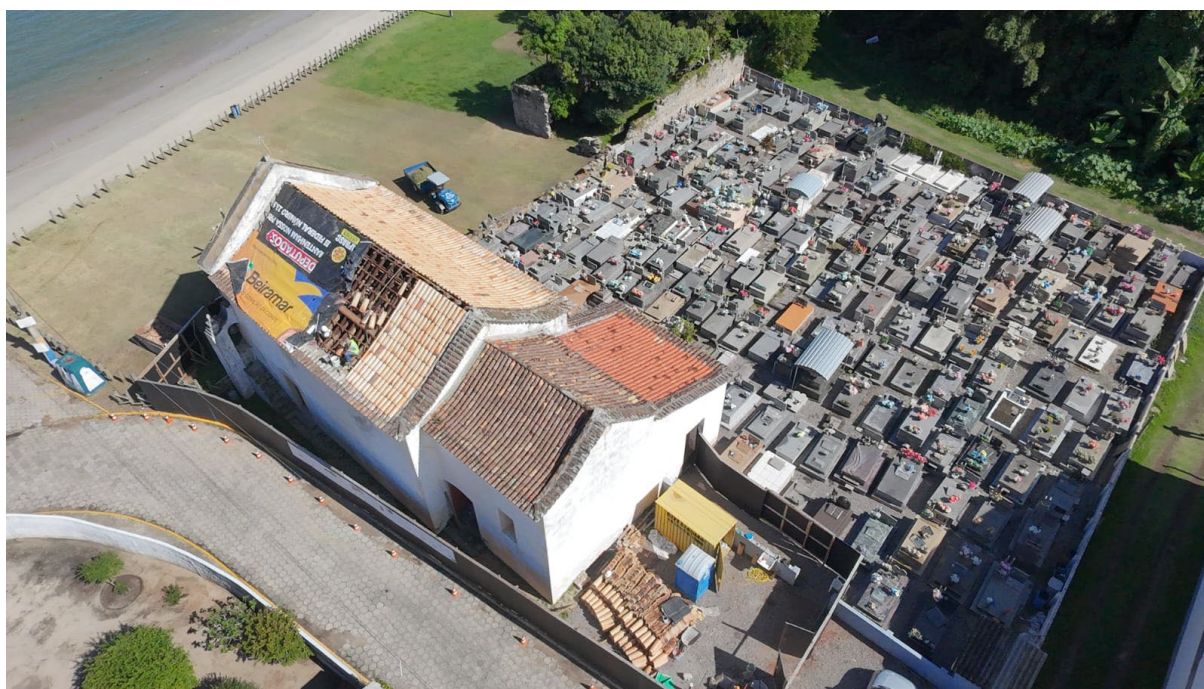
45. Execução do pano de cobertura leste da nave.
