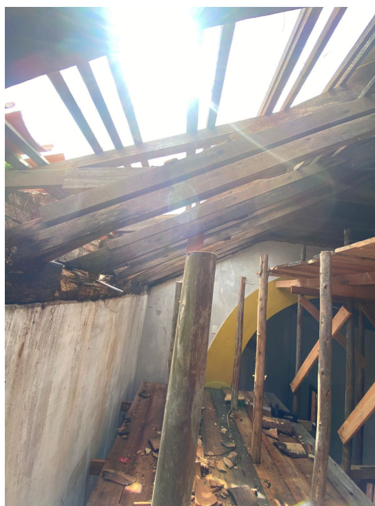
11. Inspeção dos caibros para substituição total ou parcial.
