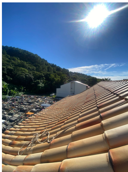
43. Etapa final do telhamento do plano oeste da nave,
