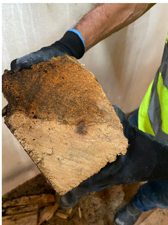
08. Inspeção das peças do de madeira do frechal e das pontas dos caibros.
