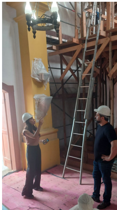
22. Eng. Paula Bogdan, da Serpa Engenharia e Arq. Guilherme Simon, da Prospectiva Arquitetura, em vistoria e acompanhamento à obra.
