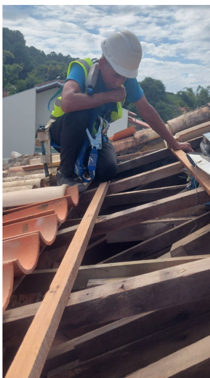
03. As ripas foram substituídas 100% por ripas novas de angelim.
