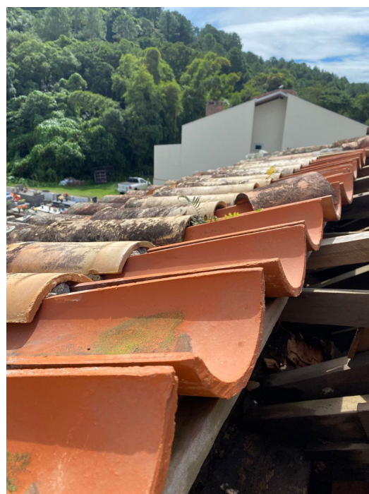
02. Cobertura da nave, lado cemitério. Retirada das telhas e verificação do beiral.
