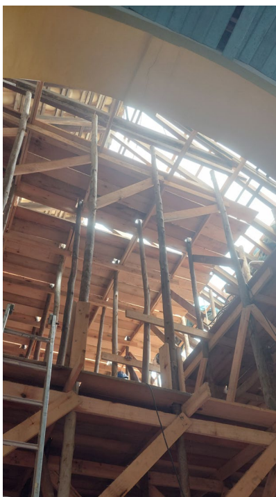
21. Andaime/plataforma – solução segura para a execução do restauro da estrutura do telhado.
