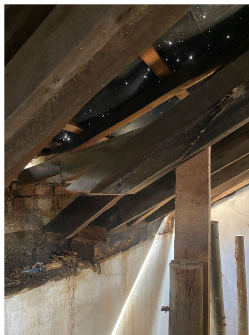
37. Limpeza da área do frechal para reinserção e complementação das peças de madeira frechal e caibros.
