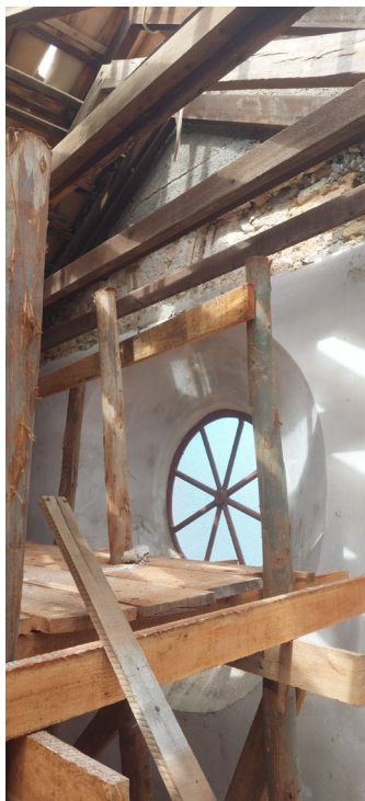
17. Vista interna do andaime/plataforma junto ao óculo frontal.
