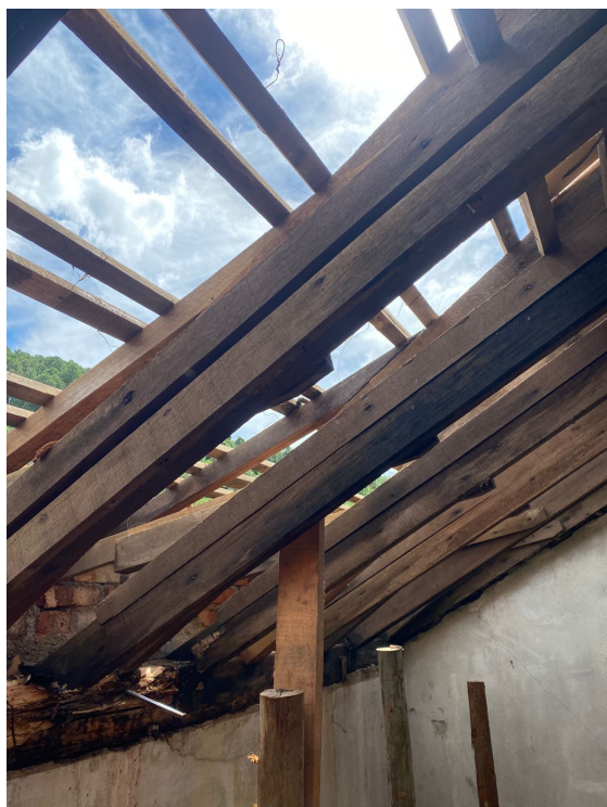
10. Detalhe das peças de madeira do encaibramento do telhado;
