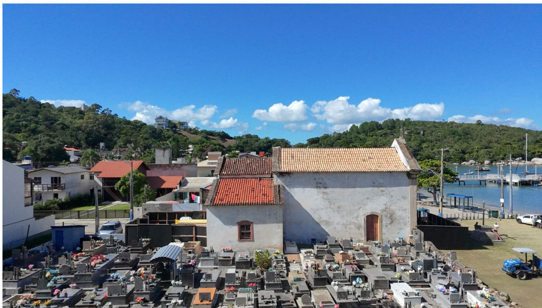
44. Etapa final do telhamento do pano de cobertura oeste da nave.
