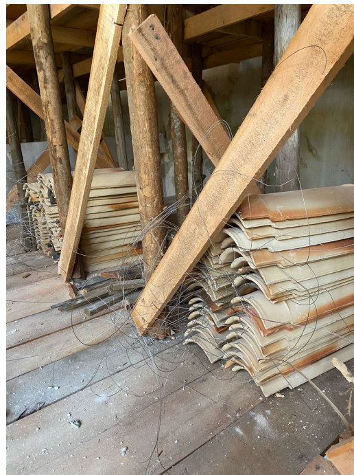
41. Telhas prontas para colocação e amarração nas ripas.
