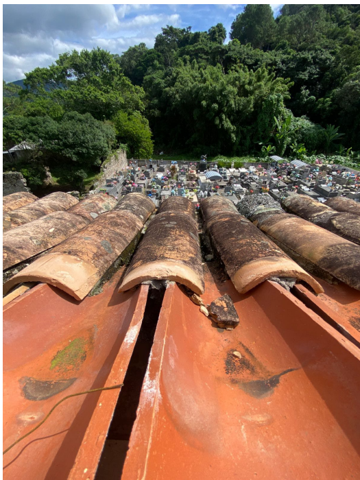
01. Cobertura da nave, lado cemitério. Retirada das telhas e verificação do beiral.
