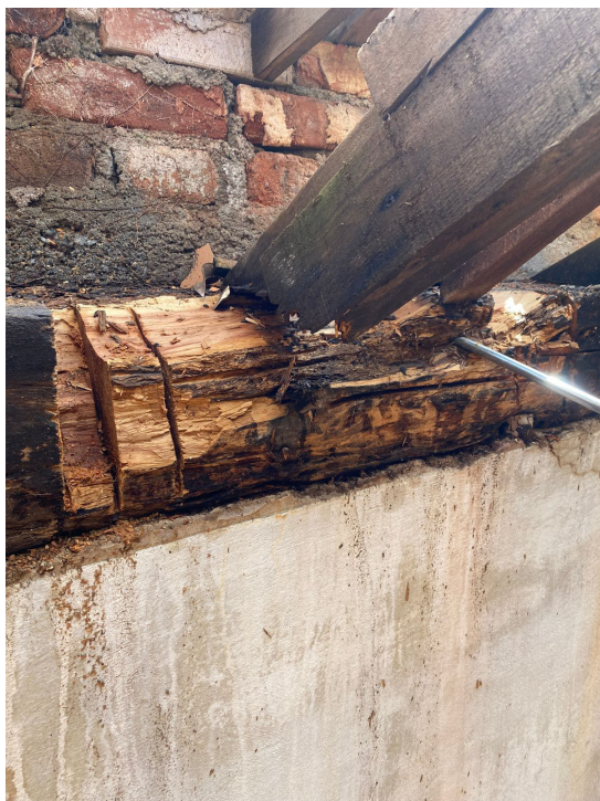
13. Inspeção do apoio do caibro no frechal.
