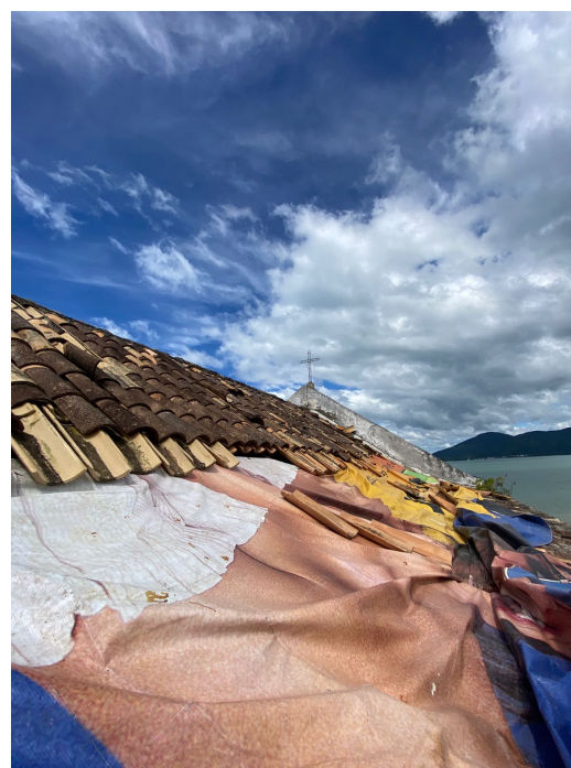
04. Cobertura provisória durante a troca das telhas.
