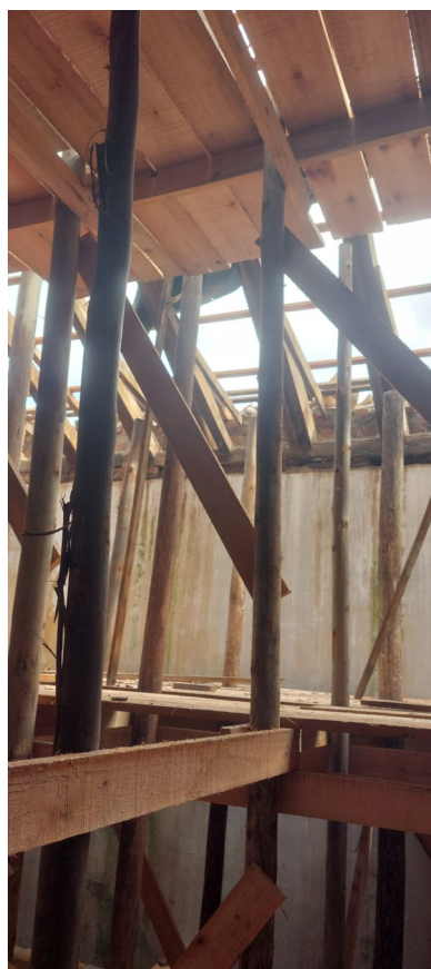
20. Andaime junto ao beiral na lateral.
