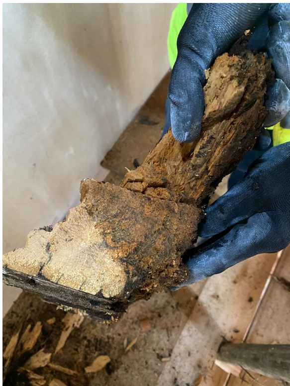
05. Inspeção das peças para substituição total ou parcial.
