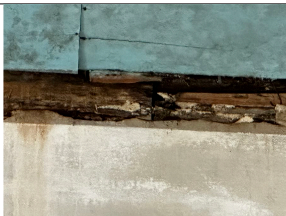
13. Detalhe de remanescentes do frechal de madeira no interior da nave.
