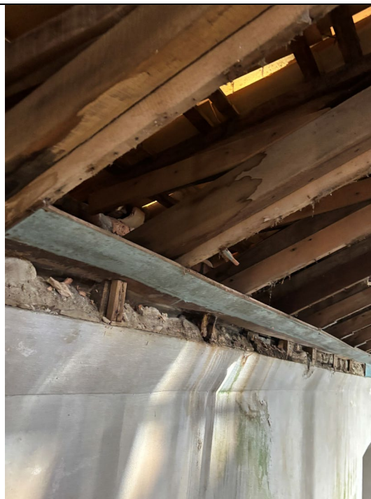
89. Continuidade da execução do segundo nível do escoramento.
