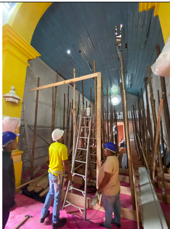
73. Nivelamento das primeiras escoras.
