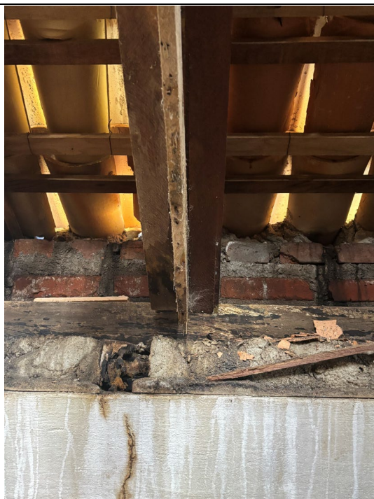
88. Detalhe do encontro no topo da alvenaria lateral, a perna do caibro.
