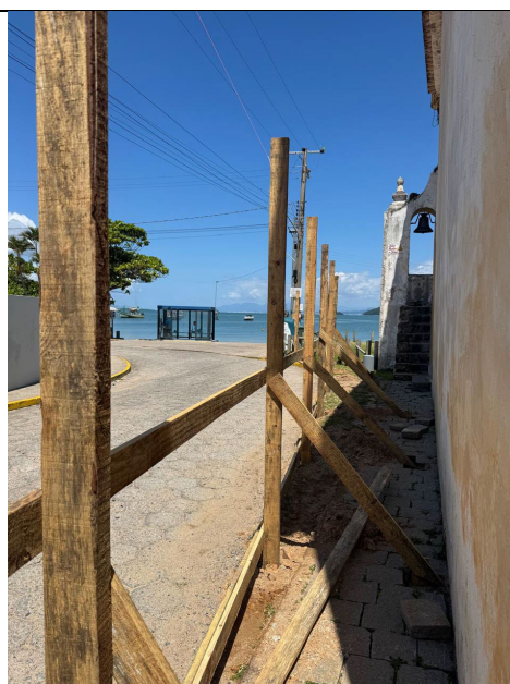
44. Colocação das estacas para fixação do tapume.
