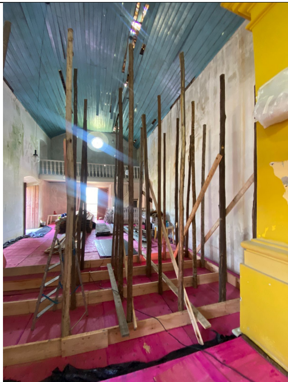
70. Início da colocação das escoras de eucalipto.
