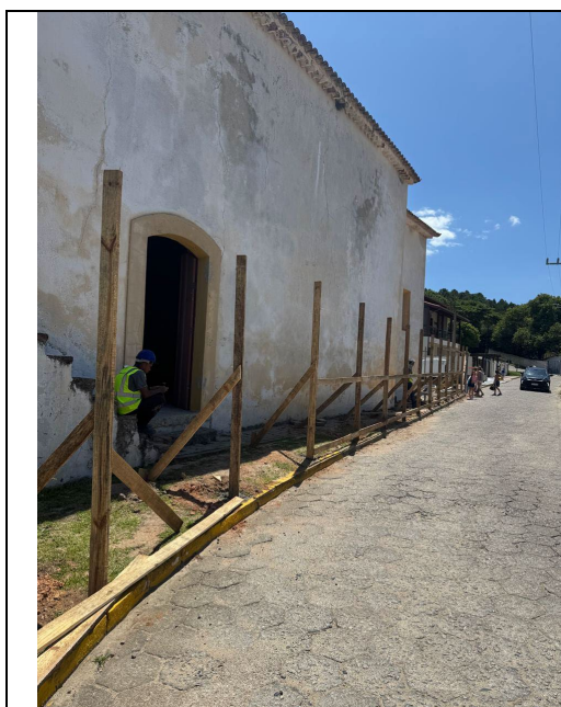
45. A locação do tapume respeitou a linha do meio-fio, lateral à igreja.
