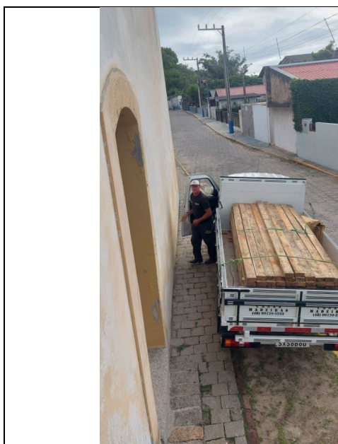
43. Chegada do material para início dos serviços – execução do tapume e canteiro de obras.
