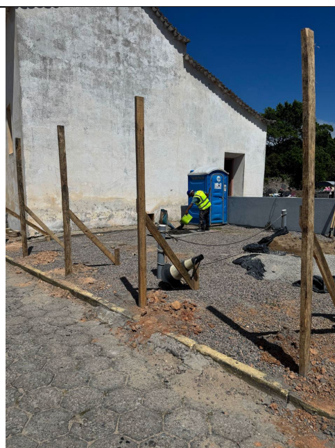
46. Extensão do tapume nos fundos para abrigar o canteiro de obras.
