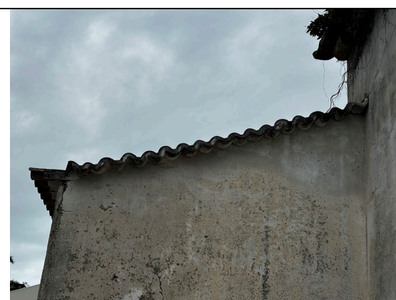
18. Detalhes do beiral em beira-seveira simplificado na lateral da sacristia.
