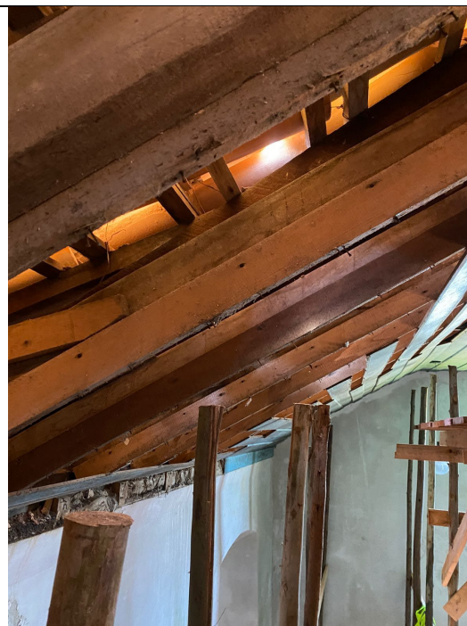
93. Vista do encaibramento com arranque do galbo.
