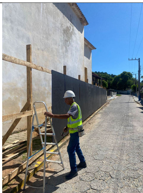
48. Execução do tapume em chapa de madeirit preto plastificado.
