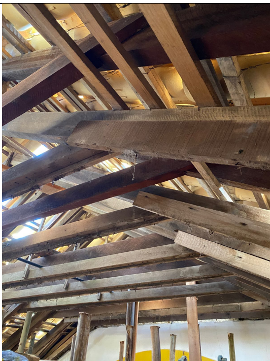
92. Detalhe do encaibramento armado, com linha alta.
