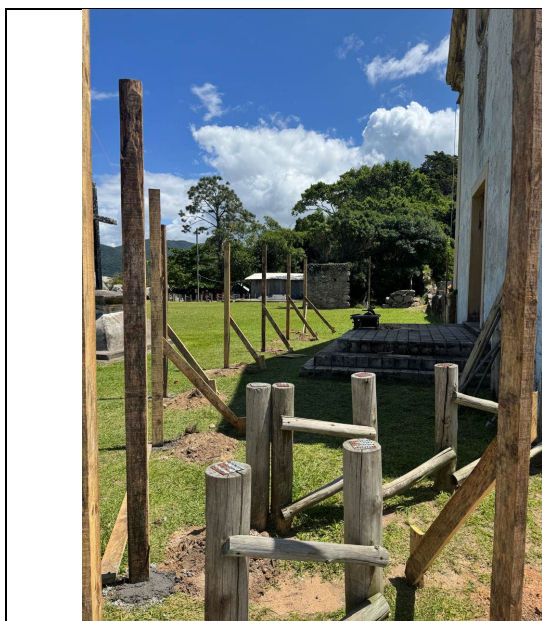
47. Na parte frontal o tapume circundou a escadaria no adro de acesso à igreja.
