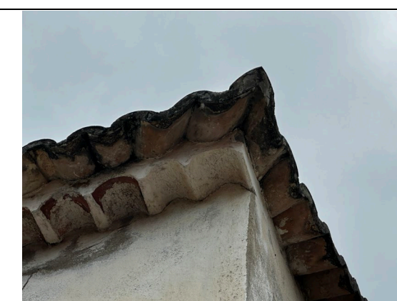
20. Detalhes do beiral em beira-seveira fachada leste. Observar o acabamento em peito de pombo.
