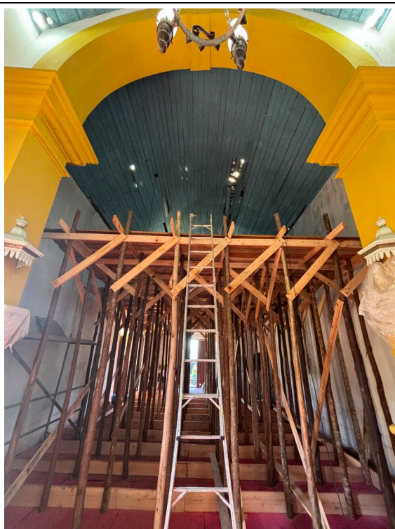
74. Colocação do primeiro piso do nível intermediário do andaime.
