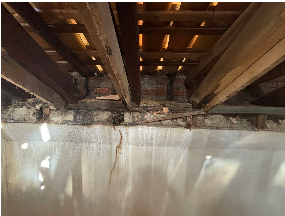
90. Detalhes dos caibros duplos e das peças de nivelamento para o forro, apoiados no frechal de madeira.
