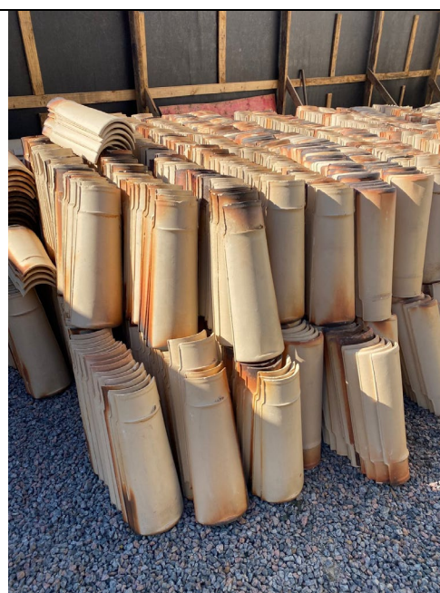
106. Chegada das telhas na obra.
