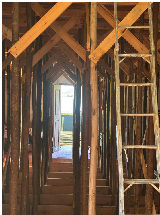
75. Observar o contraventamento de cada peça para garantia da estabilização.
