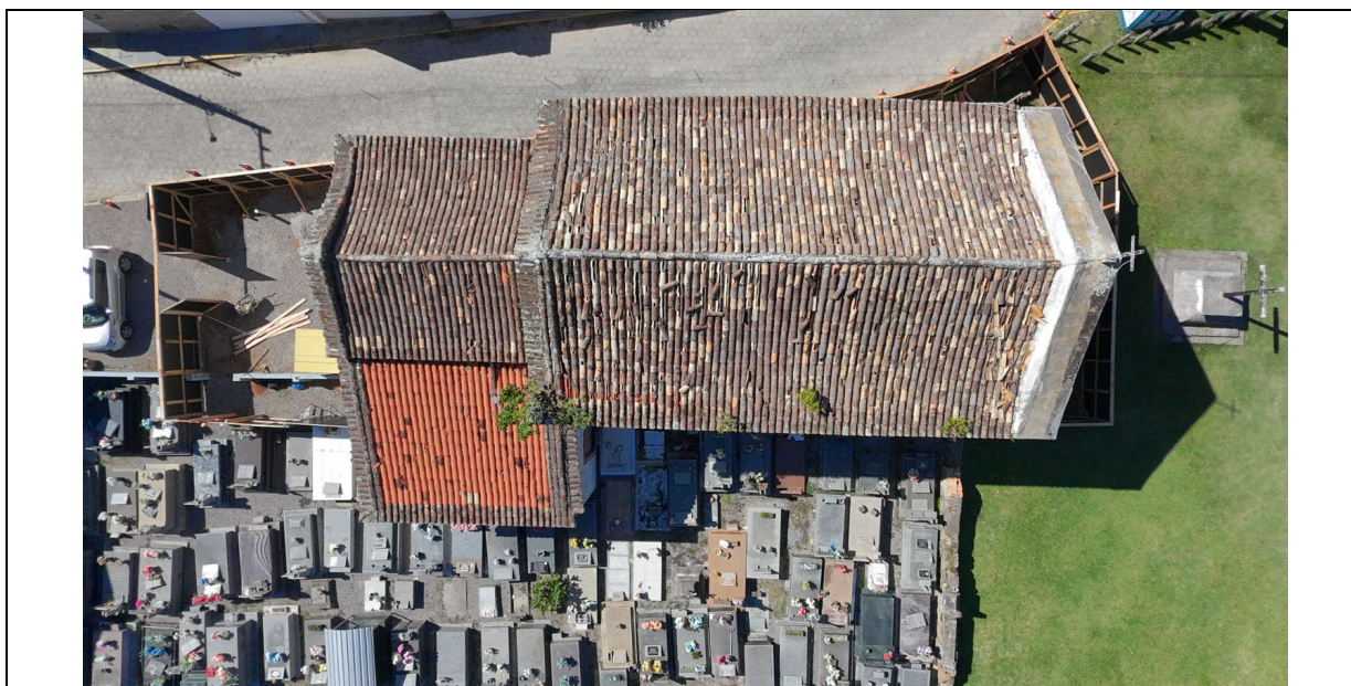
21. Levantamento da cobertura com o uso de drone para documentação dos danos no telhado.
