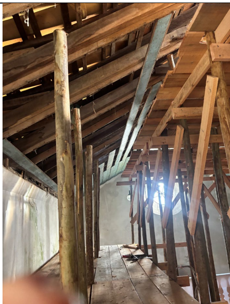
86. Segundo nível de escoras, próximo da lateral.
