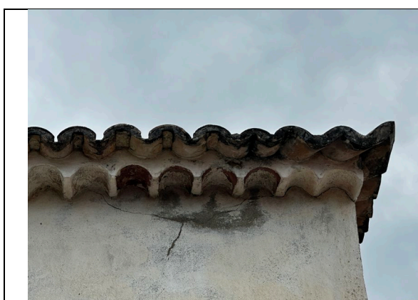
19. Detalhes do beiral em beira-seveira fachada leste. Observar o acabamento em peito de pombo.
