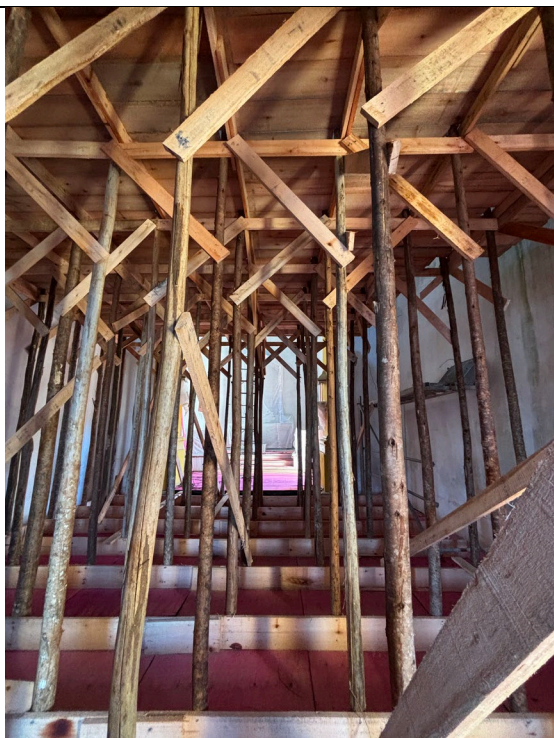
76. Peças de contraventamento na sequência das escoras.
