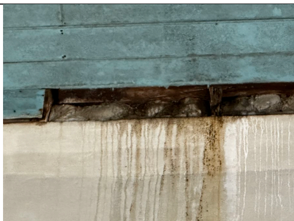
12. Detalhe do frechal no interior da nave.
