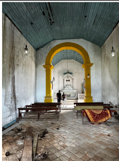
11. Vista do interior da nave.
