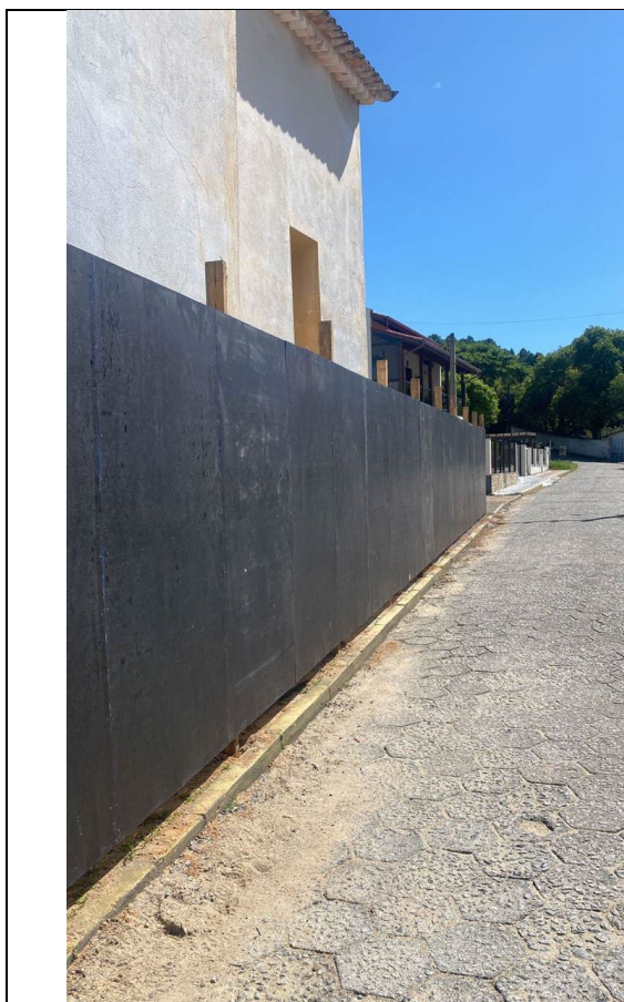
49. Proteção do piso de tijoleira cerâmica da nave.
