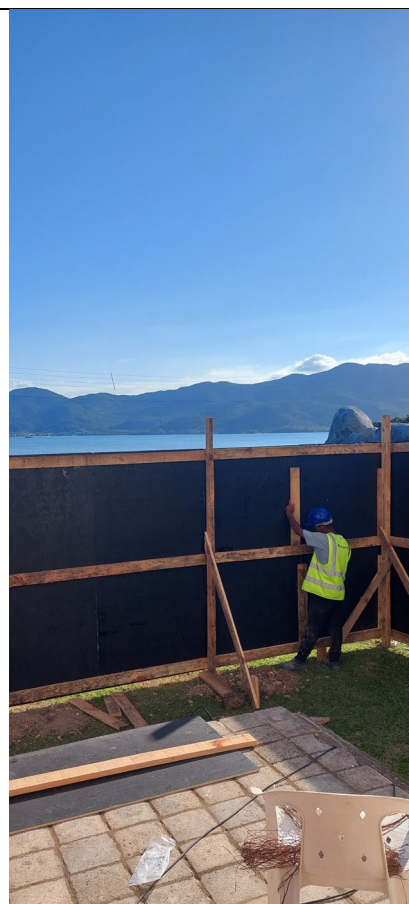
50. A estrutura foi reforçada com contraventamento em função dos fortes ventos predominantes.
