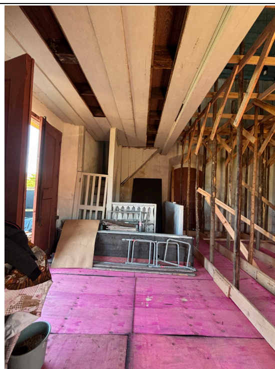
77. Continuidade da execução do escoramento.
